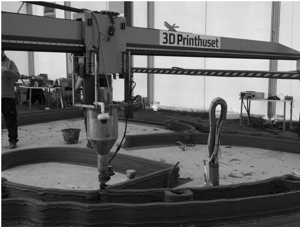
2.1. ábra. A dán 3DPrinthuset által kifejlesztett nyomtató az első európai 3D-nyomtatott épületen dolgozik. [5]
